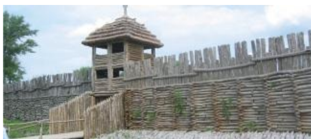
Murallas reconstruidas del poblado de Biskupin (Pomerania, en Polonia). La construcción aprovecha las características del territorio, suelos profundos que permiten la excavación de fosos y abundancia de troncos rectilíneos. Este asentamiento estuvo ocupado desde el siglo VIII hasta el II a. C. Fotografía de J. Santacana.
